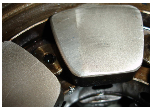
Рисунок 12 - Электроэрозионное разрушение упорной поверхности опорно-упорного подшипника турбины
